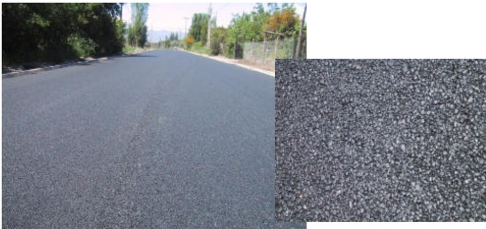
Fig. 1 Tramo experimental Microaglomerado discontinuo en caliente, Ruta E-85 Sector San Felipe-Los Andes
