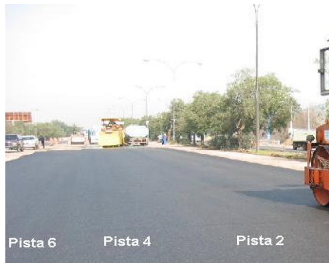
Figura 3: Tramo de prueba en Autopista Central.
