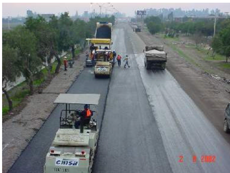
Figura 4: Compactación tramo de prueba en Autopista Central.
