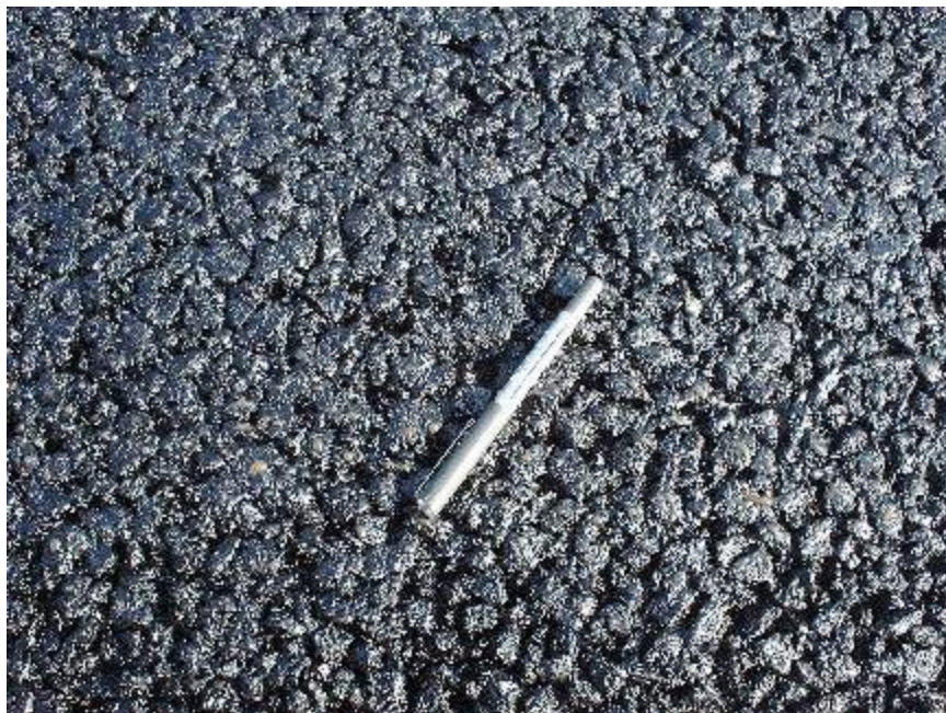
Figura 2: Mezcla SMA en terreno.
