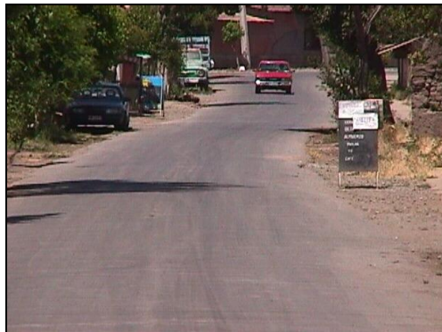
Camino con Imprimación Reforzada (Región de Coquimbo)
