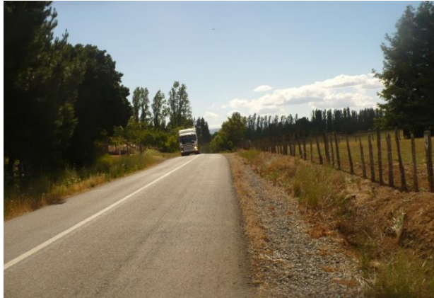
Camino con Cape Seal (Región de Los Lagos)
