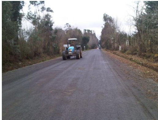
Camino con Tratamiento Superficial Doble (región de La Araucanía)
