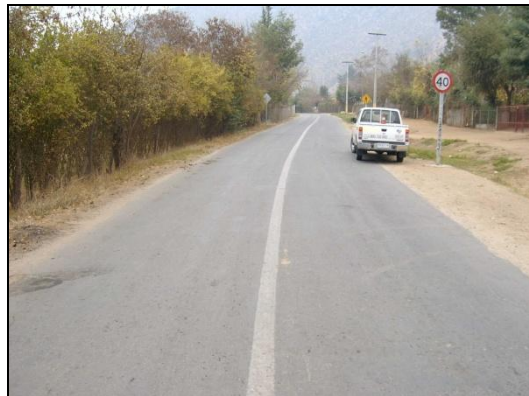
Camino con Lechada Asfáltica (Región Metropolitana)
